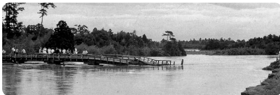
昭和35年8月の台風で崩れた川瀬橋
