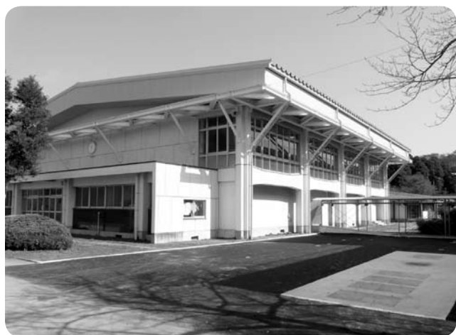
耐震補強した中学校屋内運動場
